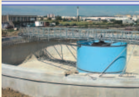
Dosadzovacia nádrž vo výstavbe.
