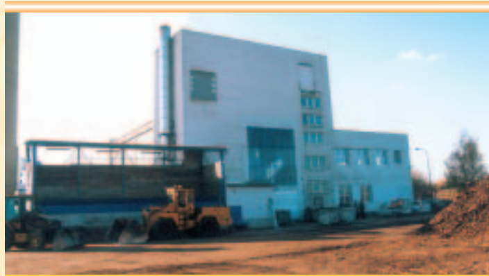
Pohľad na kotolňu. Vľavo zásobník paliva. Za sklom je vidieť časť kotla.
